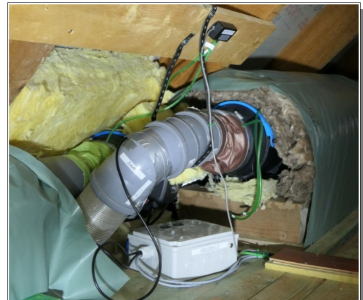
Abluftanlage im Dachboden - Lüftergruppe mit Schaltkasten und Differenzdrucksensor (oben), noch ohne Dämmung
