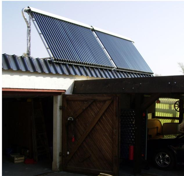
60 Chinesische Vakuum-Heatpiperöhren von Felzen Solar/ 9,6 m<sup>2</sup>
